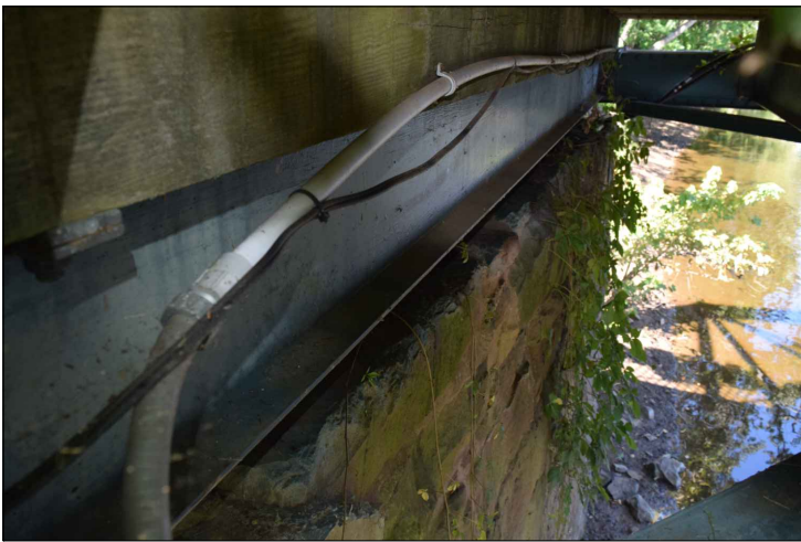
REMOVE & RESET ELECTRICAL CONDUITS
